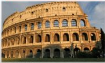
Строительство велось на протяжении 7 лет, в 72 — 80 годах
